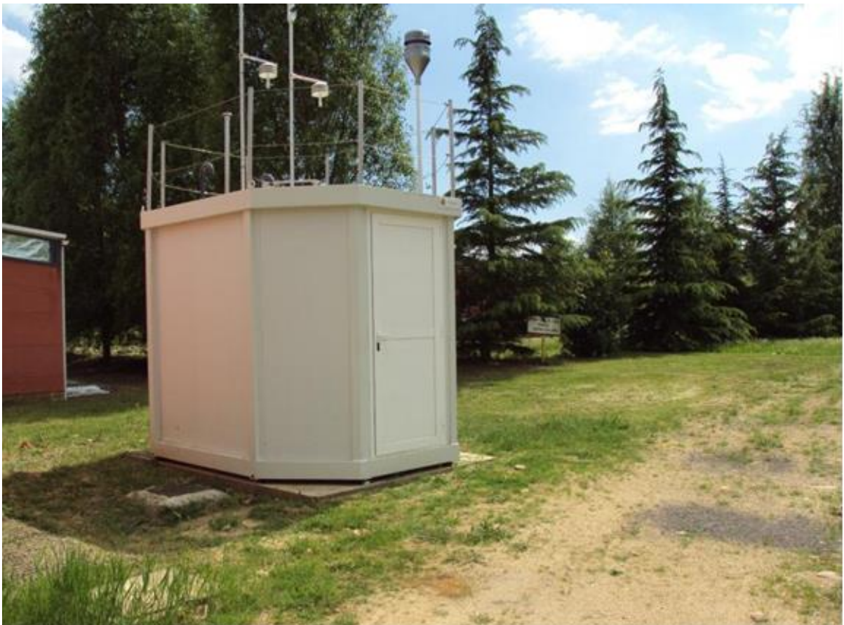
Estación 4 de medida de la Calidad del Aire (Coto Escolar)
