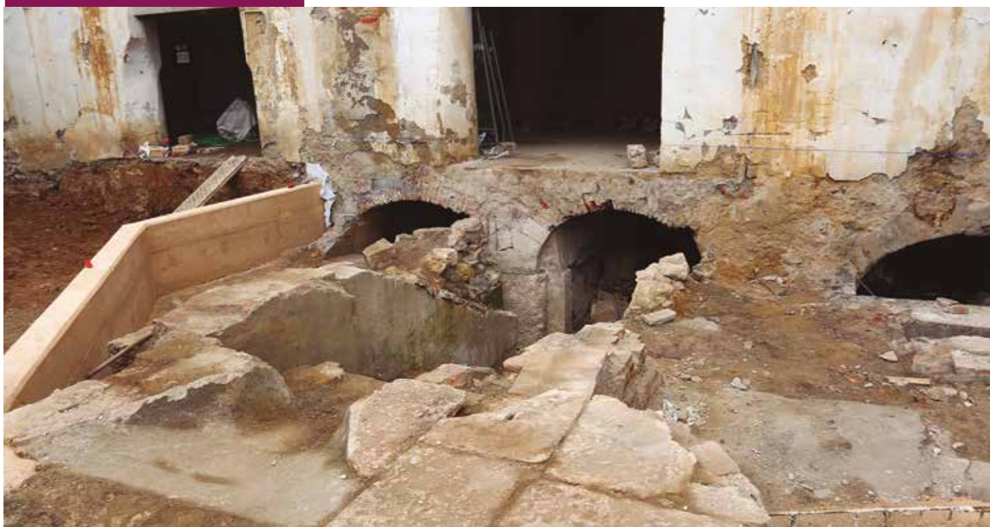
Se recuperarán los arcos de ladrillo de entrada del agua a través de las presas del río Torío
