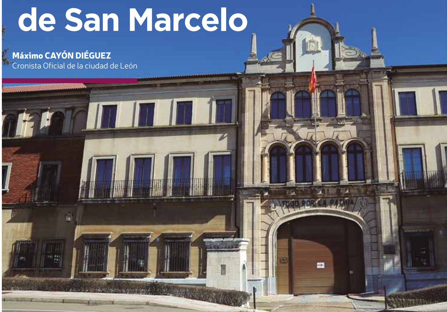
Entrada actual al complejo militar
